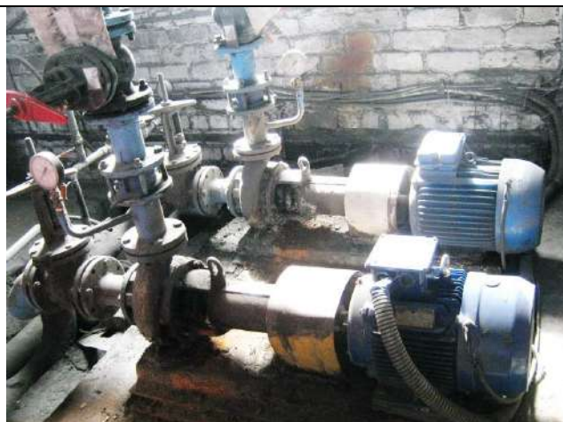
Рисунок 1.2.2 - Котельная «Центральная», сетевые насосы
