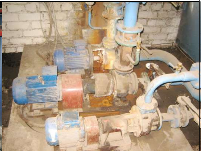
Рисунок 1.2.8 - Котельная «РОНО», сетевые насосы
