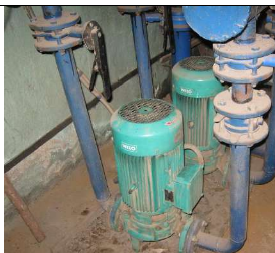
Рисунок 1.2.14 - Котельная д. Просек, сетевые насосы
