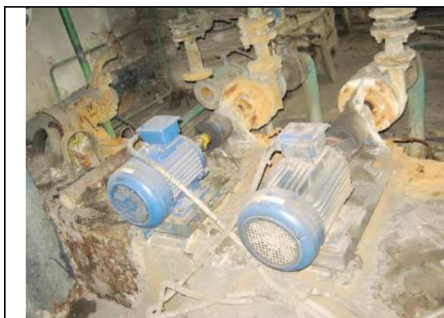
Рисунок 1.2.11 - Котельная по ул. Энергетиков, сетевые насосы
