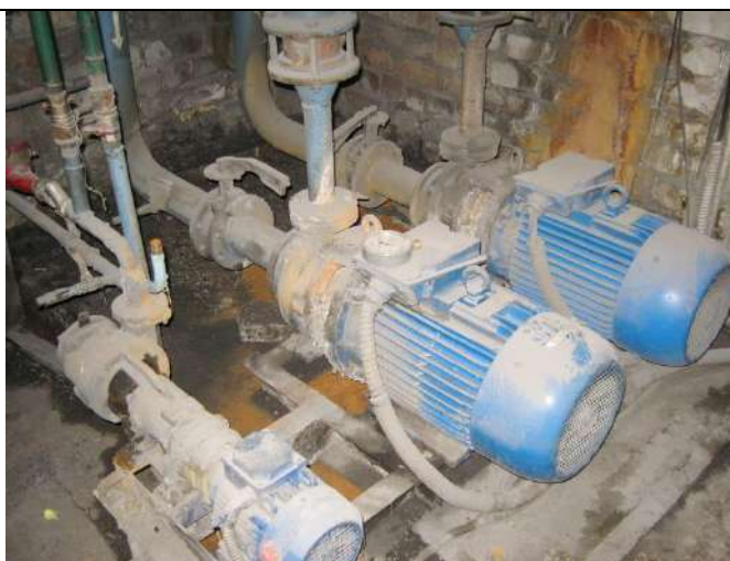
Рисунок 1.2.5 - Котельная ЦРБ, сетевые насосы
